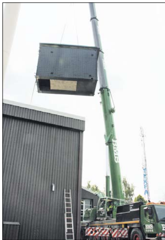
Kraftkarlen »Becky« havde ingen problemer med at løfte kedlen på 20 tons op over hallen.
